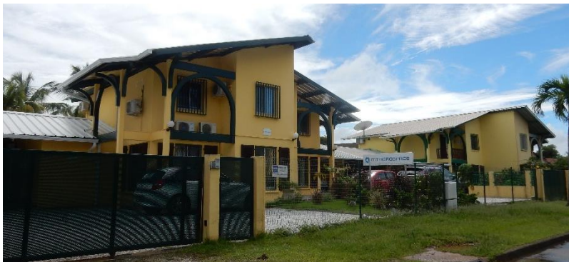
Opération d'individuel groupé, quartier Bois Chaudat (Source : la boîte de l'espace)
