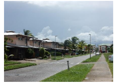
Exemple de qualification de la transition rue / espace bâti: le cheminement et les bordures bétons contiennent les espaces enherbés et assurent la continuité du parcours piéton. Un seuil incluant stationnement et plantations assure la transition entre les maisons et la rue.
