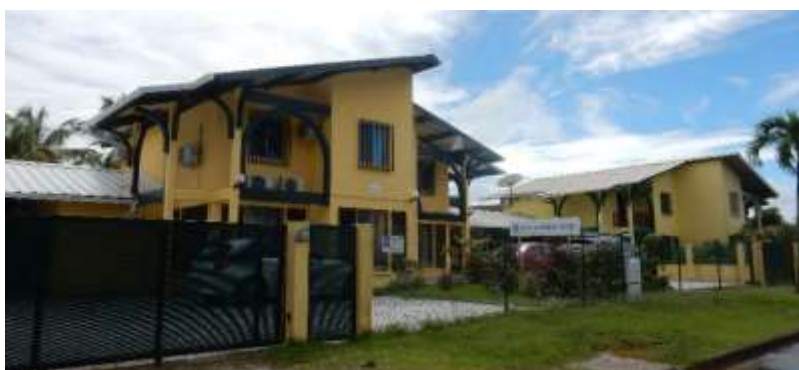
Opération d'individuel groupé, quartier Bois Chaudat (Source : la boîte de l'espace)
